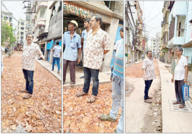
প্রগতি সত্ত্বে থেকে সাত নম্বর অঞ্চল অবধি বিস্তৃত রাস্তা পৌরপিতা নবরুজ তৈরি করে দিচ্ছেন। সাথে উন্নত মানের নিকাশি ব্যবস্থা। এই সামগ্রিক কাজ সমাধান হলে আগামী দিনে ওই এলাকার মানুষজনদের যাতায়াতের সুবিধা এবং উন্নত নিকাশি ব্যবস্থার উন্নতি ঘটবে। সেই রাস্তারই অগ্রগতি পরিদর্শন করলেন পৌরপিতা শ্রী মনীষ মুখার্জী। যে সকল কর্মী এই রাস্তার কাজ করছেন তাদের তিনি কাজের গুণগত মান চিন্তে তা বোঝালেন সাথে এলাকার মানুষের সাথে কথাও বললেন।
